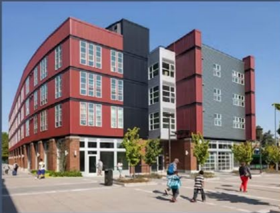
Artspace Mt. Baker Lofts // Seattle, WA
